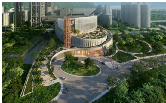
台泥和平廠內興建的再生資源利用中心外牆 UHPC 帷幕
